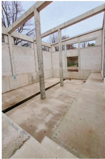
Wasserwerk West: notwendiger Neubau bei steigendem Wasserbedarf in Langen.
